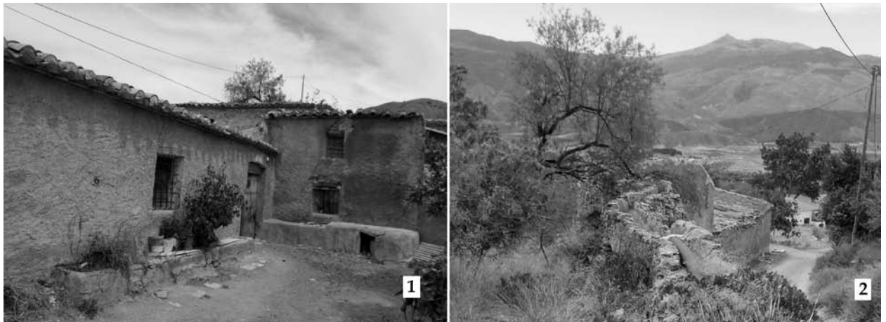
Figura 8. (1) Vista actual exterior de la edificación donde se encontraba el molino hidráulico de pulverización de jaboncillo que poseía Manuel Berruezo en Somontín, así como (2) vista de la acequia elevada que conducía el agua hasta el molino. Posteriormente se le conoció como molino de los Gazpachos o de los Castellones.
