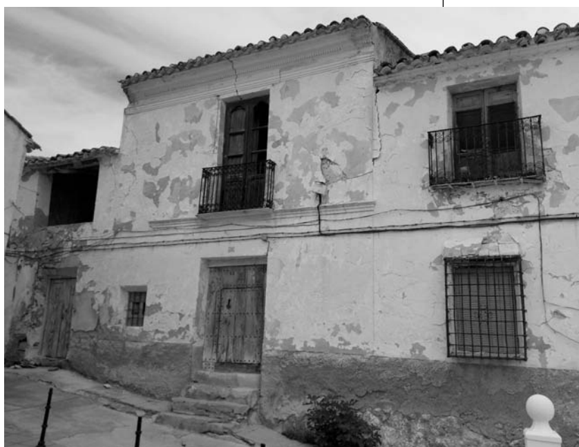
Figura 3. Vista actual de la casa que perteneció a Manuel Berruezo Ayora, ubicada en la calle de la Iglesia, en Somontín.
