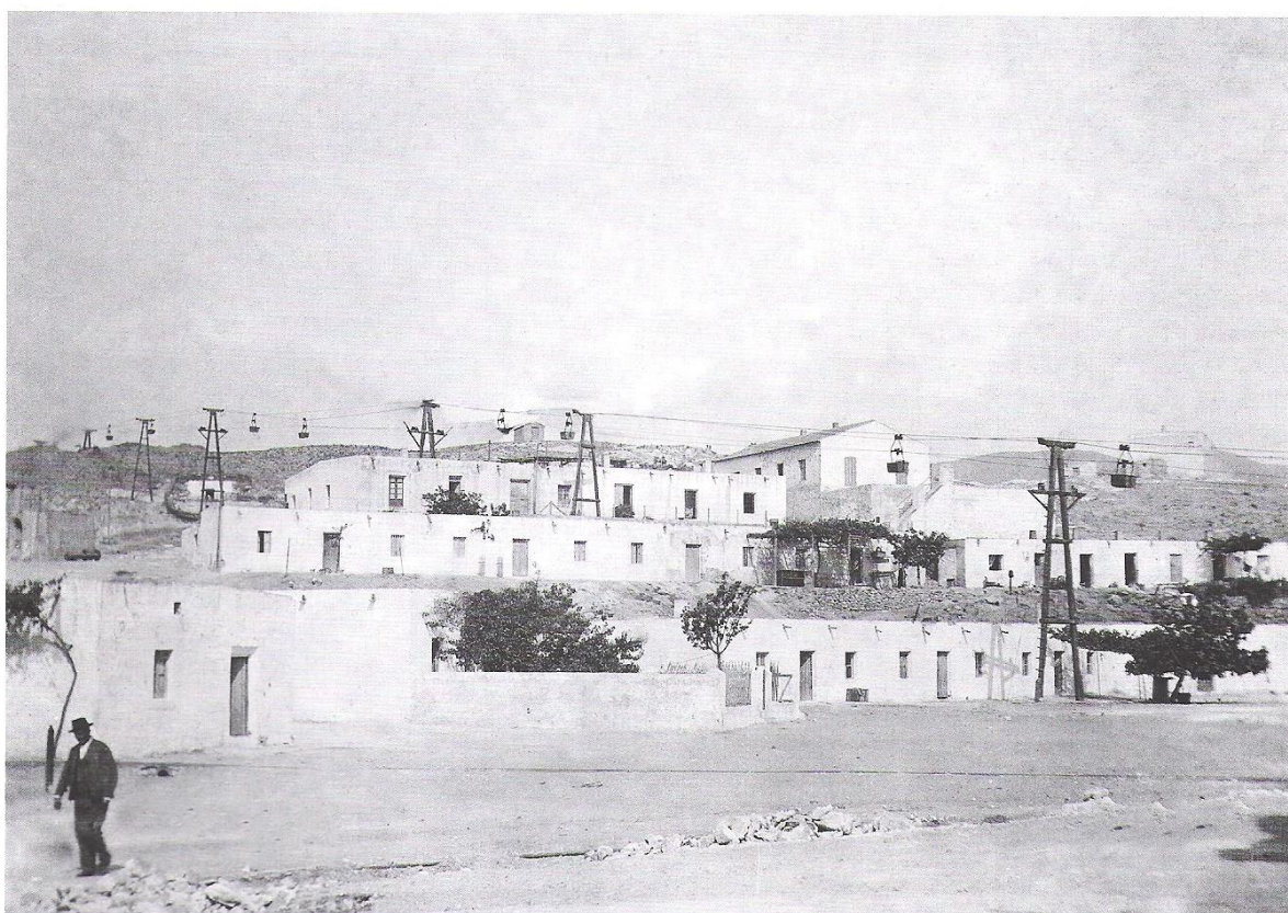
Barrio Alto de El Pinar de Bédar alrededor del año 1910. Se observan las viviendas características de bloques alargados de un solo piso y cómo el barrio era cruzado por el cable aéreo que venía desde la estación de carga de Serena.
