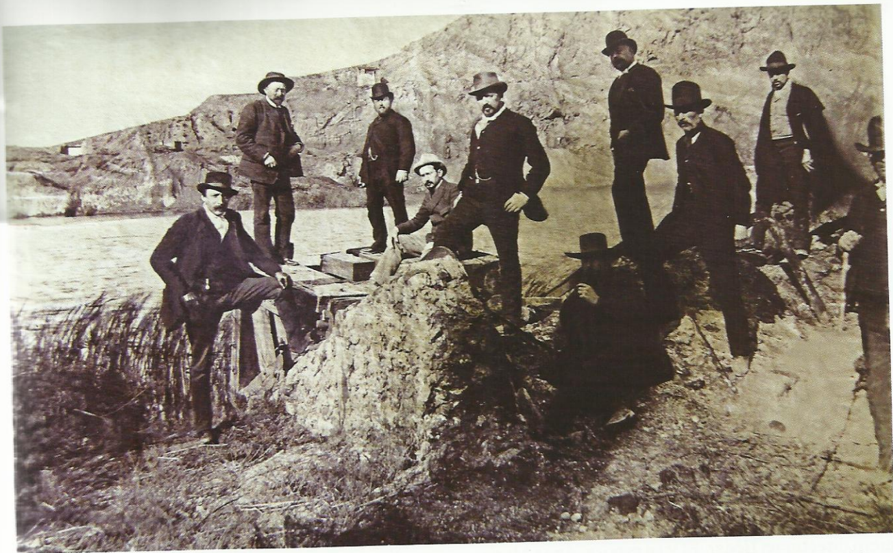
Varias personas posando ante una roza de Herrerías completamente inundada. Se puede identificar al ingeniero Fredrik Dietrichson a la izquierda y a Guillermo Bobrzyk justo a su derecha, de pie sobre la plataforma. Podría tratarse de la visita realizada por los ingleses de la casa Borner a las rozas de Herrerías, en las que estuvo presente Bobrzyk y los ingleses Peile y Evans, para estudiar su desagüe, tal y como se recoge en La Crónica Meridional de 17 de mayo de 1890. (Fotografía cortesía de la familia Pérez Preus)
