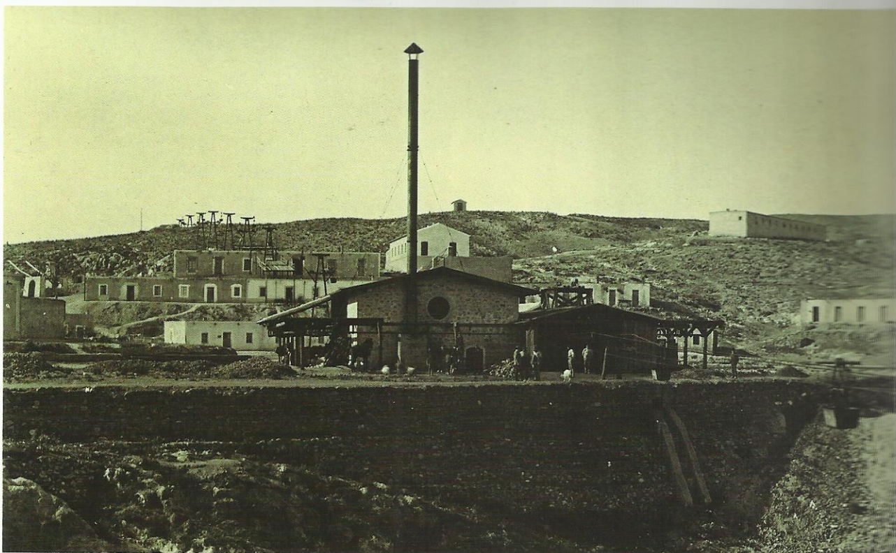
Estación de ángulo del cable aéreo Bédar-Garrucha en El Pinar de Bédar (Archivo Gustav Thorkildssen, cortesía de Tuva Halbo)
