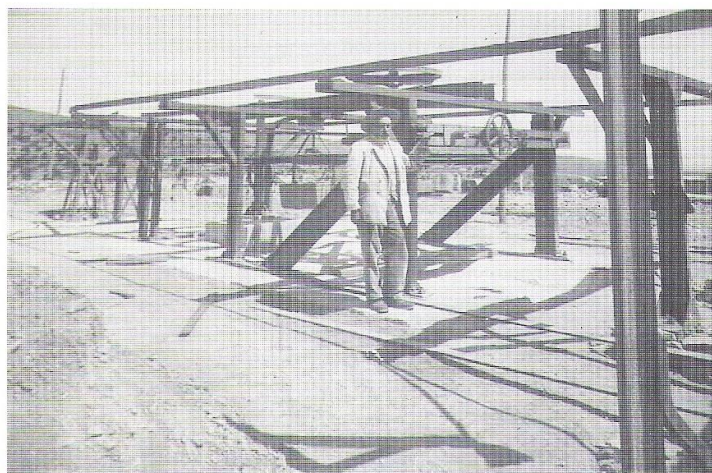
Instalaciones del cable de Majá la Cana en Tres Amigos .
