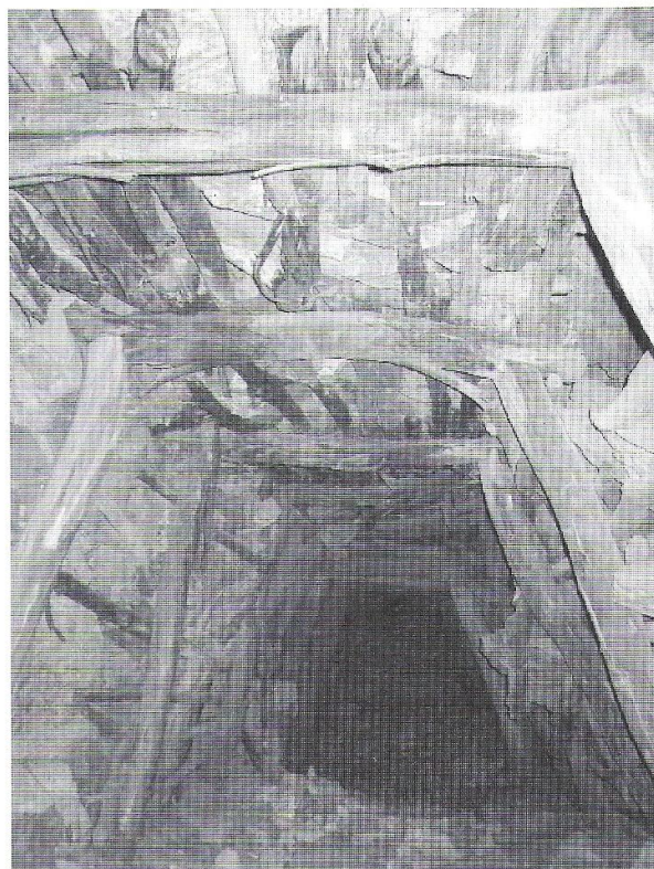
El trabajo de entibación que se conserva en la mina de Alerta .
