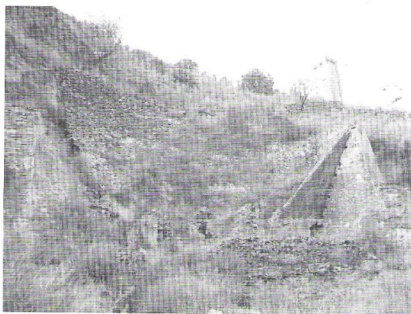
Tolva de la mina del pozo Esperanza.
