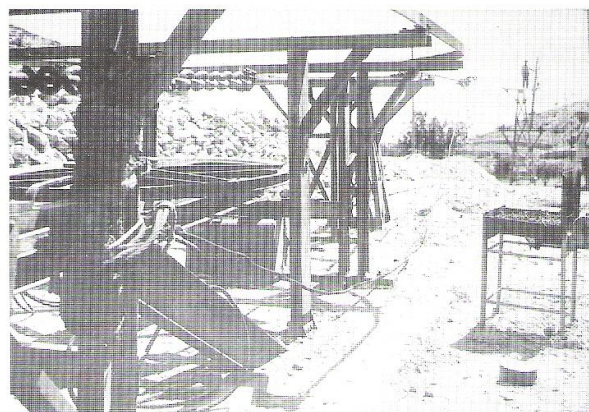
Instalaciones del cable de Majá la Cana en Tres Amigos.
