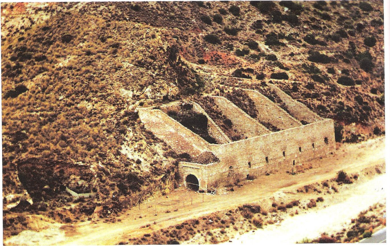
Foto 12a.- Conjunto de las tolvas-depósito de regulación y cargadero de «Tres Amigos»
