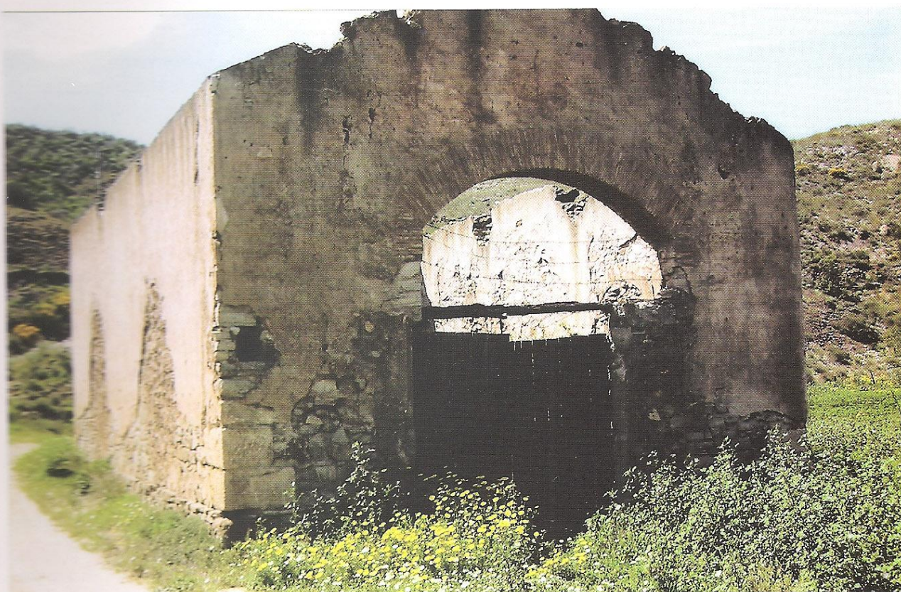
Foto 14.- Caseta taller de la locomotora 020T «Catalina»
