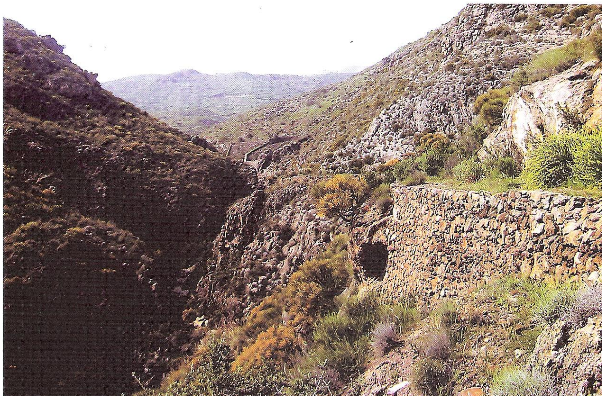
Foto 21.- Obra de mampostería auxiliar de la Vía Vulcano en la ladera Norte del Barranco de los Lobos. Al fondo las tolvas de Vulcano
