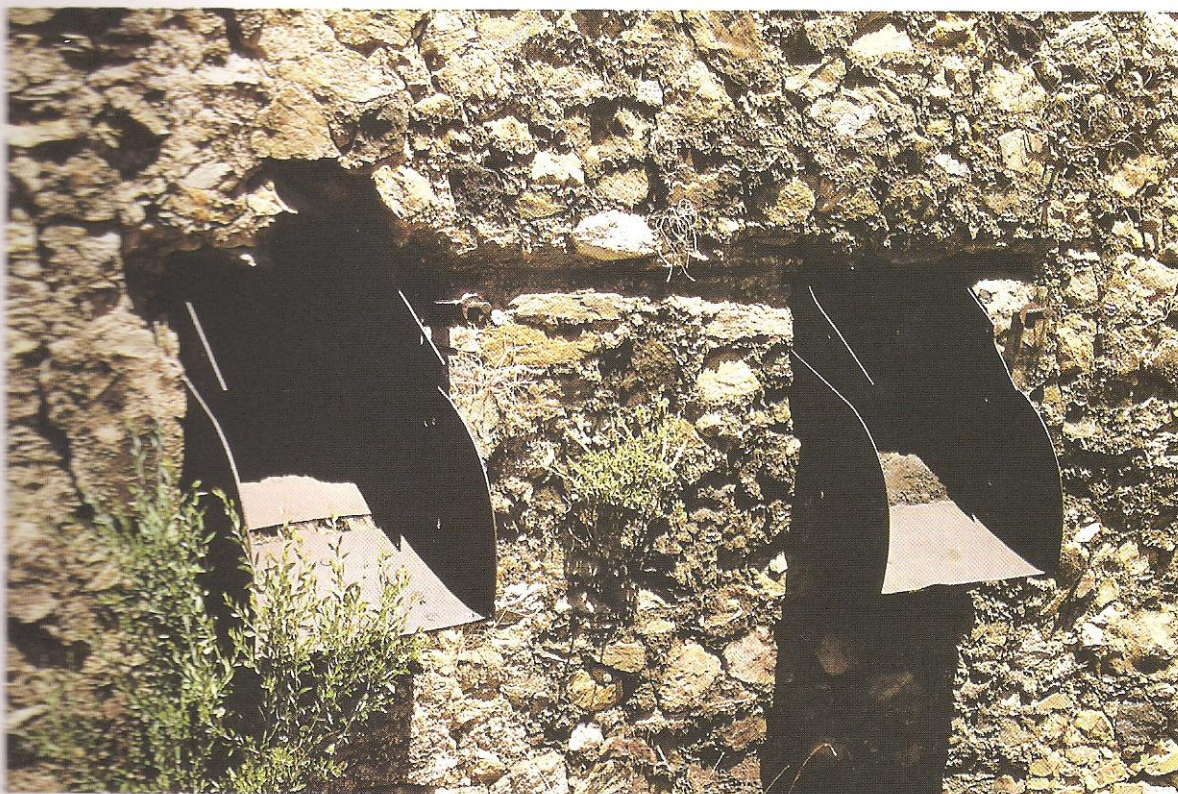
Foto 31.- Detalle de las compuertas de descarga de una de las tolvas de Vulcano
