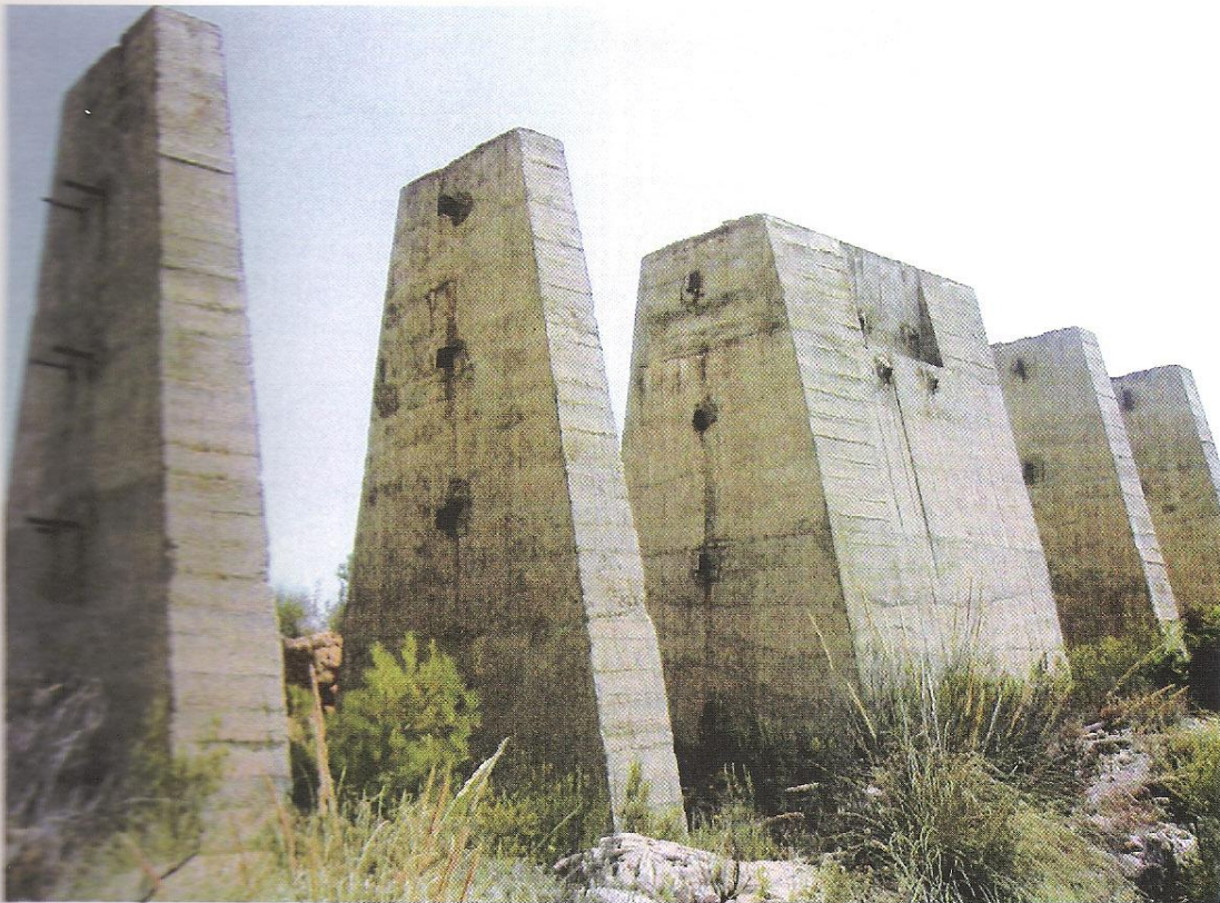
Foto 19.- Restos de lo que debió de ser una estación tensora del cable aéreo de San Manuel a Garrucha
