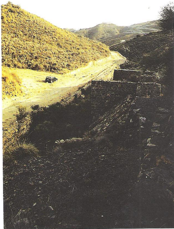
Foto 36.- Mina «Cuatro Amigos». Estación del Cable y tolva de carga.
