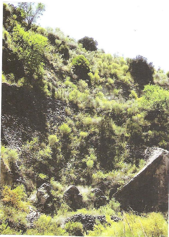
Foto 26.- Tolva de embudo de «Esperanza». La exuberante vegetación del Barranco de los Lobos la acabará destruyendo
