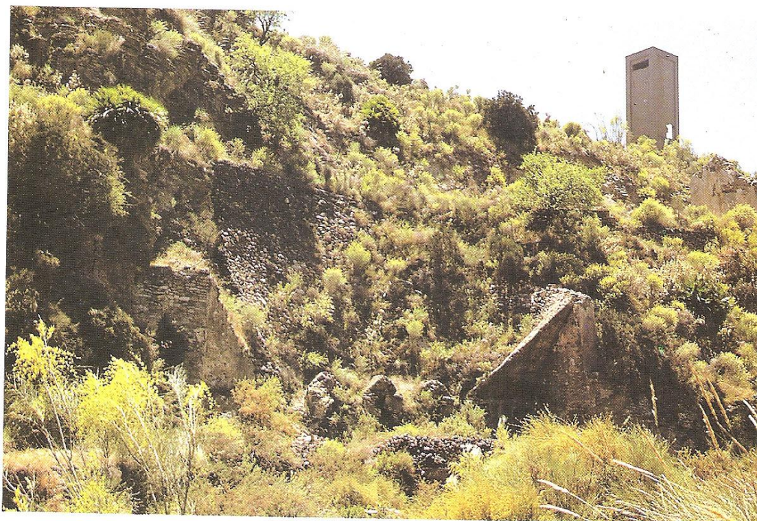
Foto 27.- Otra vista de la tolva sobre la cual se observan restos de construcciones y la torre del transformador
