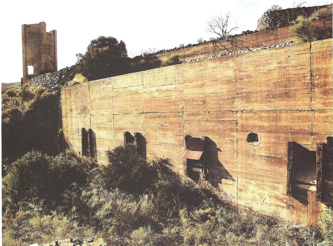
Foto 33.- Tolva-cargadero del tranvía aéreo que parte de la estación de Serena
