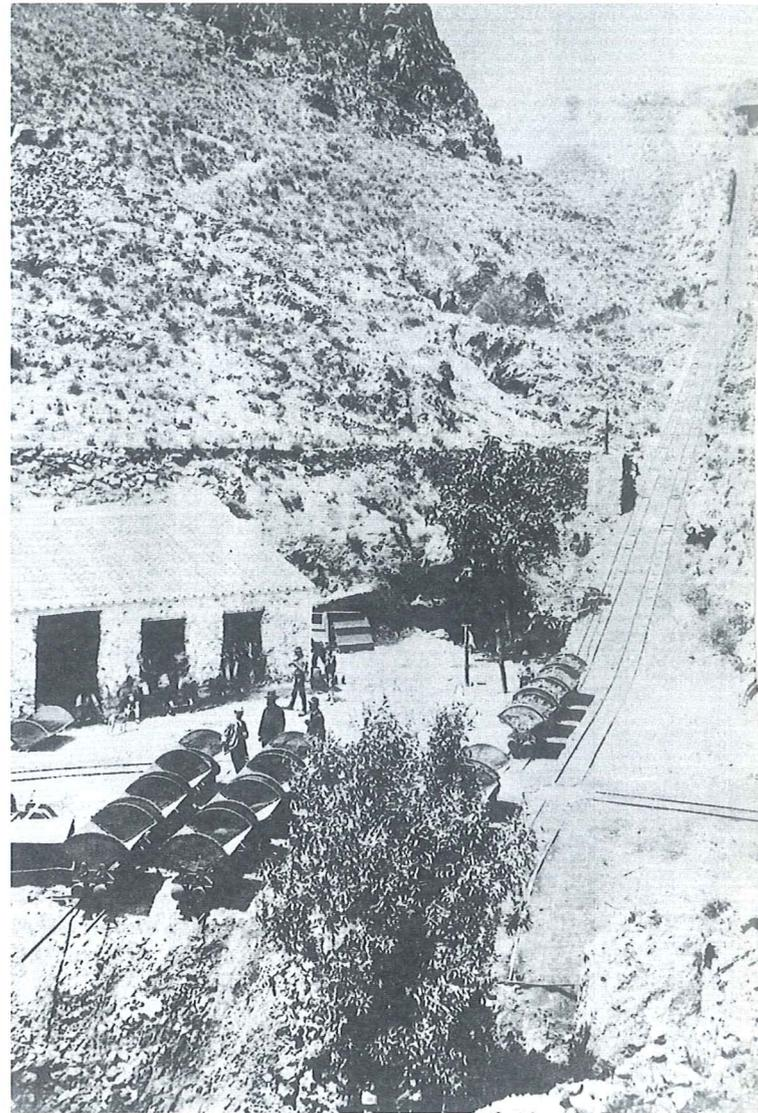
**El "Plano Grande de Serena" en Bédar. El mineral llegaba procedente de las minas "Porfiado" y "Júpiter" hasta el cargadero del Cable Aéreo de la "Compañía de Águilas" De la obra "Trenes, Cables y Minas de Almería". Ed. I.E.A. Almería-1994.**
