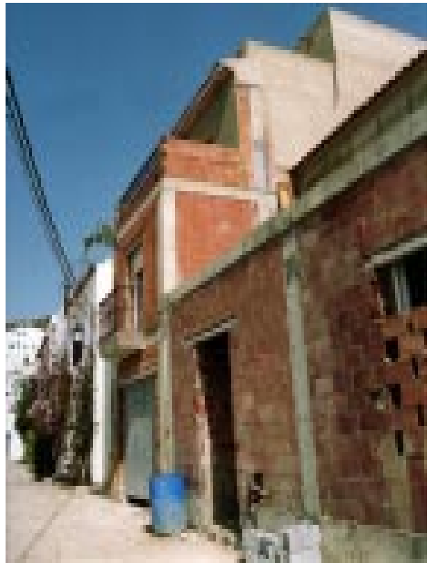
Fachada principal de la casa, con un nuevo balcón, posterior a la prohibición y materiales de construcción utilizados. La tercera planta exige un mayor retranqueo. La cuarta sobra. (foto G. Leal, 2 de mayo de 2008)
